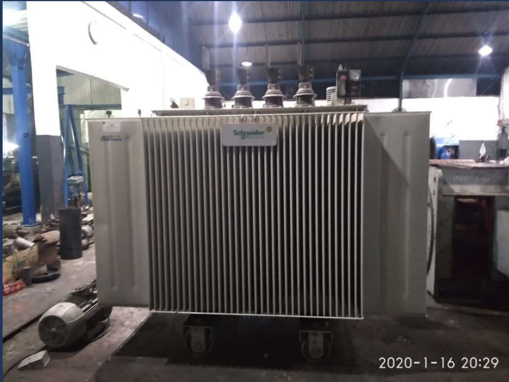
Trafo 2500 kVa PT. PURINUSA (SINAR MAS) BANDUNG
